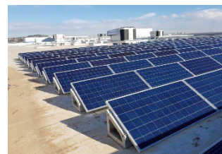
Instalación con Solar block
