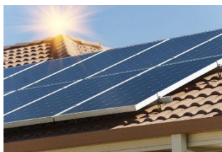
Instalación coplanar
